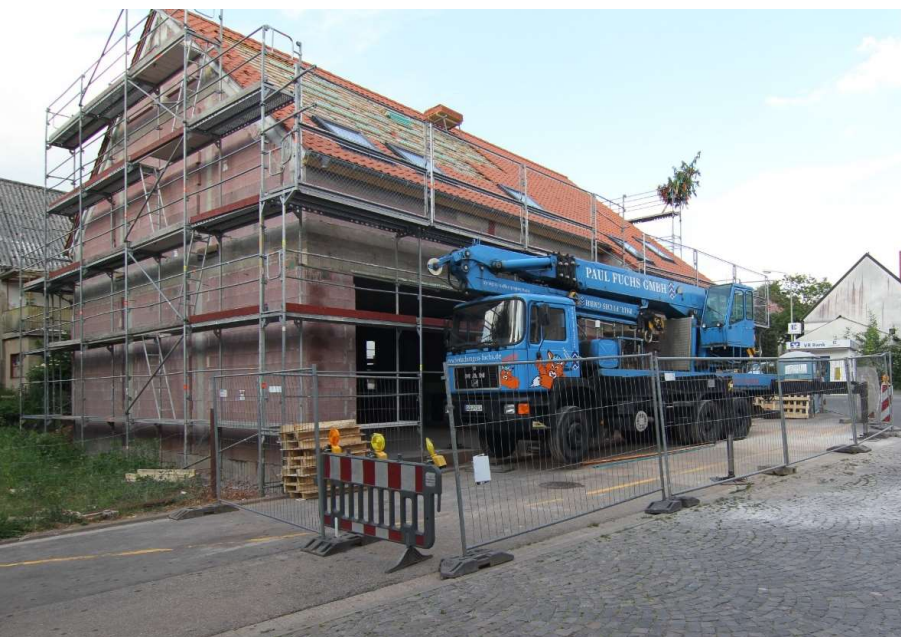
Richtfest zum Neubau des Feuerwehrgerätehauses 2011, Fotograf: Fredi Brabänder, Stadtarchiv Blieskastel, Sammlung Fredi Brabänder
